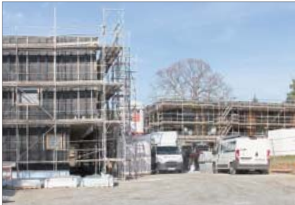
Der Weg für den Haushalt 2020 ist frei. Zu den kostenintensivsten Projekten der Bautzener Stadtverwaltung gehört der Bau einer neuen Kindertageseinrichtung am Schützenplatz. Dort laufen aktuell unter anderem die Arbeiten an der Außenfassade, zeitgleich wird im Inneren der Gebäude verputzt. Foto: Kevin Auerswald
